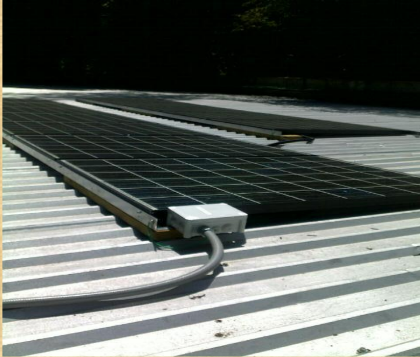
Paneles Fotovoltaicos Capacidad 2.6 kW
